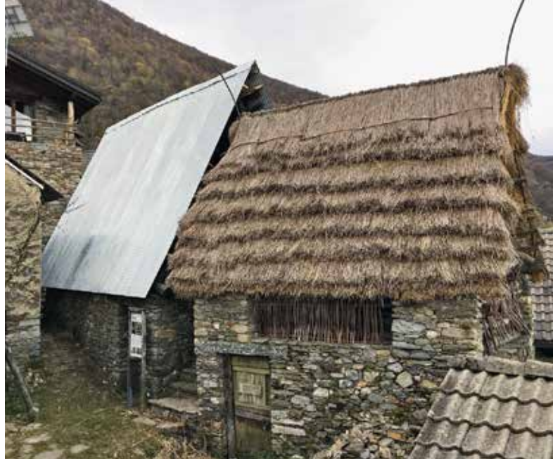
Vista due tetti
